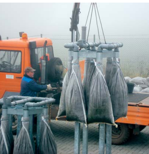
Abheben des Gestelloberteils Bild 7 mit sieben Filtersäcken zur Lagerung für die Trocknungsphase (Herbst)
